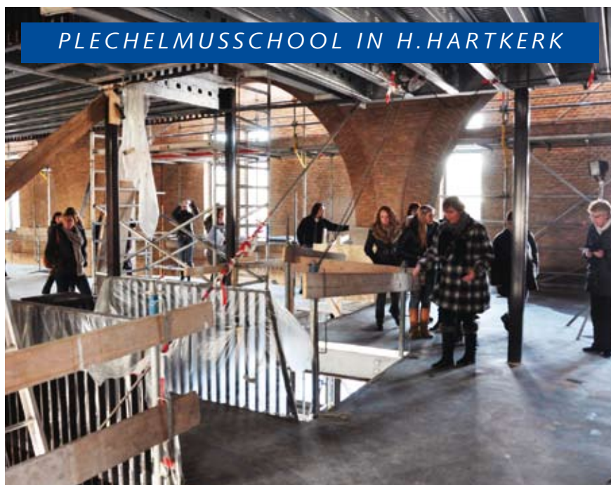
We waren met het team in ons nieuwe gebouw en staan hier op de 1e verdieping in de toekomstige groepen 3. We kijken door het trapgat naar beneden in de kleuterlokalen. Aan de overkant van het bruggetje komen de bovenbouwlokalen. Links nog de (werk)trap naar boven naar de vide, waar extra werkplekken komen.
